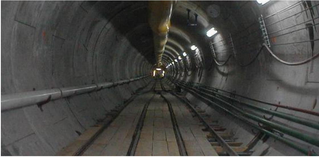
Túnel Río de la Compañía, en construcción.
